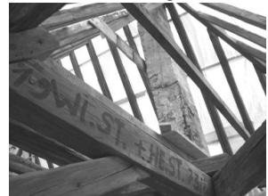
Beim Austausch von Dachsparren kam es zu gefährlichen Schwankungen des Kamins, so dass dieser vermutlich auch noch abgetragen werden muss.
