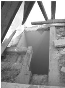
Auch im Dachbereich kamen wesentlich größere Schäden zu Tage, als ursprünglich erwartet. Große Teile der umlaufenden Lagerhölzer und Dachsparren waren auszutauschen. Ebenso ein Deckenbalken, wobei die Decke zum Obergeschoss durchbrochen wurde, die eigentlich bei der Sanierung unberührt bleiben sollte.
