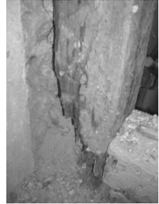
Nach Austrocknung der Wände soll ein atmungsaktiver Innenputz aufgebracht werden. Das Aufsteigen der Nässe im Mauerwerk wurde durch ein Verfahren der Firma „isotec“ unterbunden. Alle 12 Zentimeter wurden in Fußbodenhöhe Bohrungen in die 80 cm starken Außenmauern eingebracht. Mit Heizstäben wurden diese Bohrlöcher und die umgebende Wand auf 200 Grad erwärmt. Flüssiges Parafin wurde in die Bohrlöcher eingespritzt und soll sich flächendeckend verteilen und so eine Wassersperre bilden.
