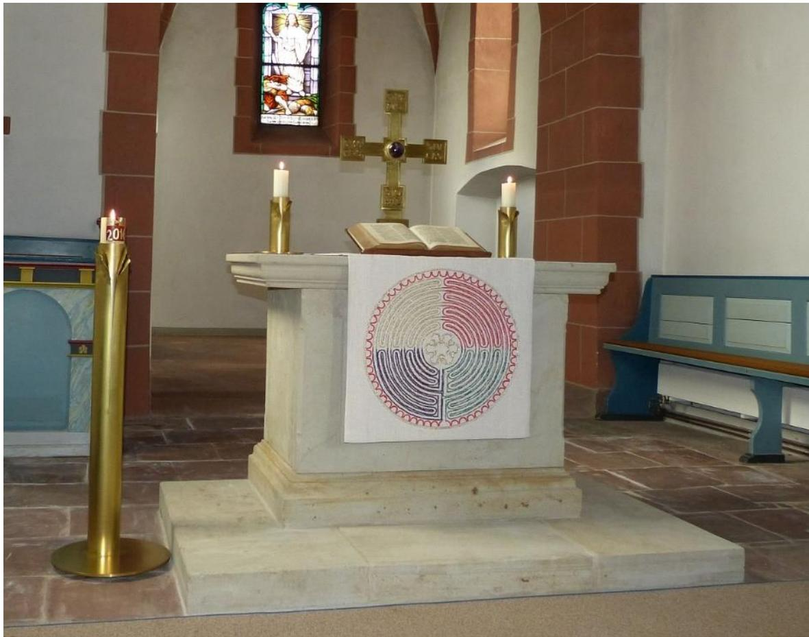
Auch in dieser Zeit wurde an den Sandsteinplatten vor allem im Bereich Altarraum einige Ausbesserungen vorgenommen. Hier schadet aufsteigende Feuchtigkeit dem alten Steinmaterial (frühere Ver fugungen haben eine Verdunstung unmöglich gemacht), so dass sich ständig unschöne Flecken bilden, die auf Dauer auch den Platten schaden.
